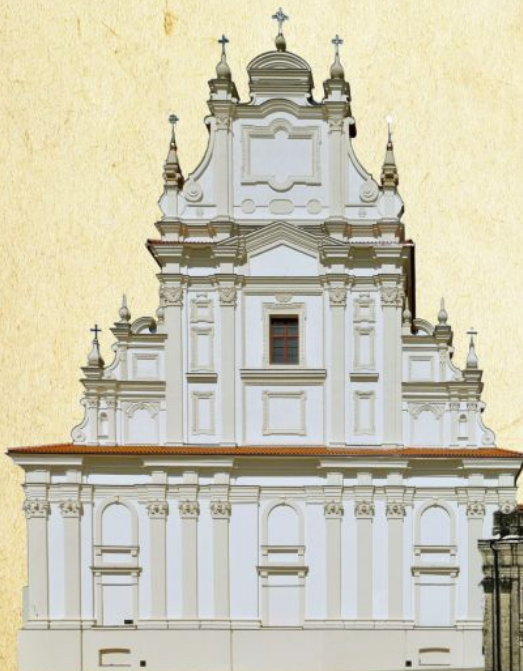
Dawny kościół Franciszkanów po przebudowie na koszary, źródło: Zamościopedia Obiekt po renowacji w 2021 r., źródło: Domena Publiczna
